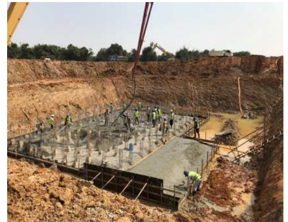
取水場施工現場（トンレサップ湖近隣）
