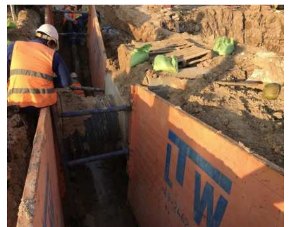
配水管施工現場（既設の下水道管渠に近接しており、慎重な作業が求められます。）
