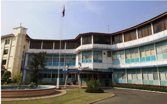
プノンペン水道公社本館 1階に北九州市海外事業サポートセンターがあります。
