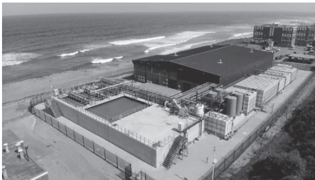
写真-4 海水淡水化・下水再利用統合システム（南アフリカ共和国ダーバン市）
