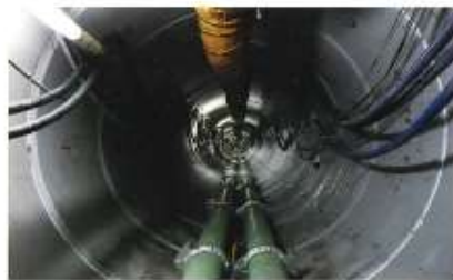
長距離施工イメージ Image of a long distance pipeline construction
