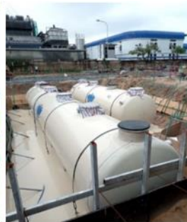
現地据付状況
