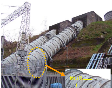
発電所装備例
