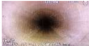
管渠更生工法により甦った管路
