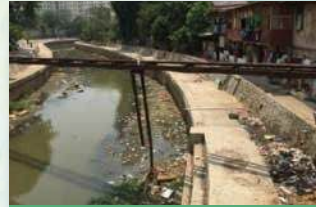
ジャカルタ市内河川の汚濁状況
