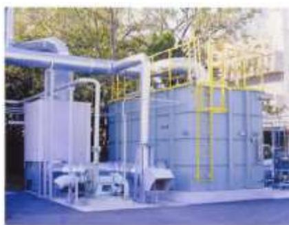
排ガス中の水銀除去装置
