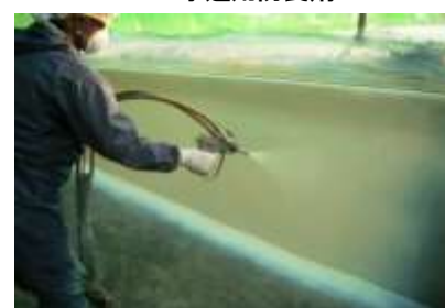
急速施工補修工法
