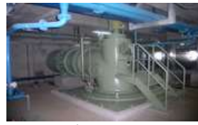
雨水ポンプ(φ1200)設置工事
