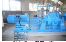
送水ポンプ設置工事
