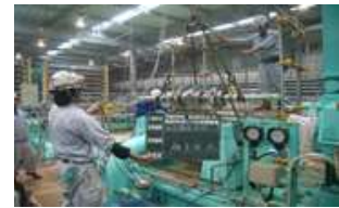
海水淡水化高圧ポンプ定期修理
