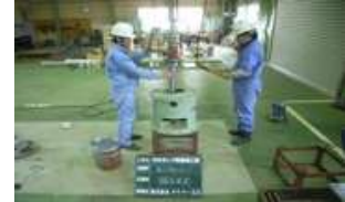
汚水ポンプ整備工事
