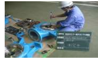
海水淡水化低圧ポンプ定期修理
