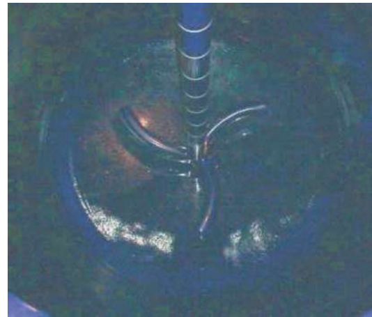
腐食性の高いガラスライニングタンク Aggressive corrosion Glass lining tank
