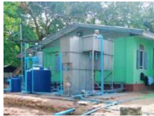
浄水設備(ミャンマー)
