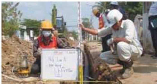
管路布設工事の指導をする廣渡博さん(右、2010年)
