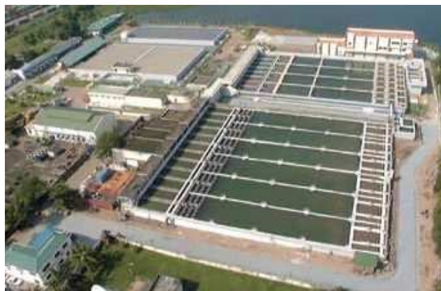
改修後のプンブレック浄水場
