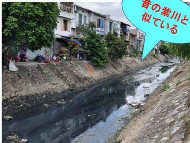
現在のハイフォン市の河川 家庭のトイレからの排水は腐敗槽（セプティックタンク）で処理されて河川に排水されている。また、雑排水はそのまま河川に排水されている。
