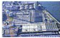
日明浄化センター 昭和45年4月運転開始
