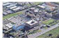
北浜浄化センター 昭和47年4月運転開始
