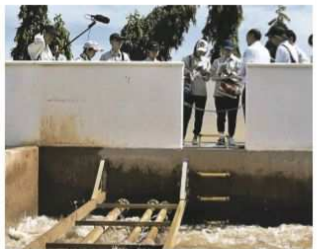
プンブレック浄水場を視察する北九州市の高校生たち。原水は茶色いが、徐々に透明になる ＝8月9日、プノンベン
