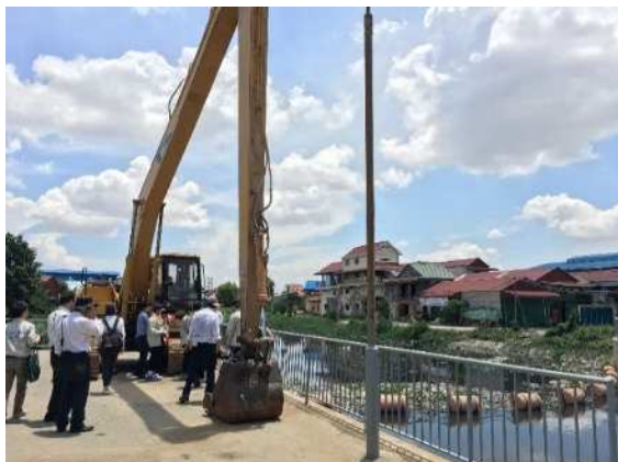
トンプンポンプ場見学
