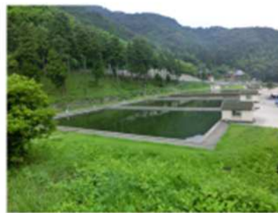
道原浦浄水場:緩速ろ過方式
