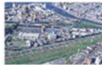
皇后崎浄化センター 昭和38年7月運転開始
