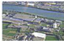
曾根浄化センター 昭和54年10月運転開始
