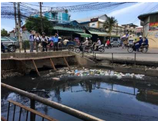
汚れたトラベック水路の様子
