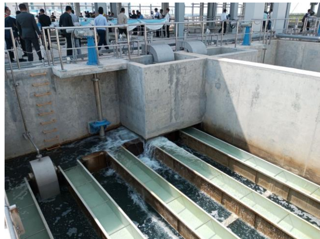
新浄水場施設視察
