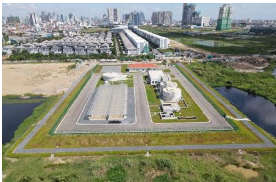
完成したチュングエック下水処理場
