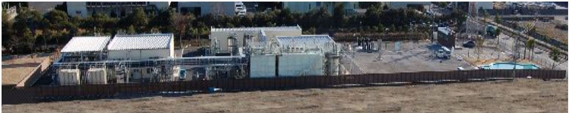
●ウォータープラザ北九州内 トイレ用水・薬品希釈水・洗浄水など場内水として利用 (水道水使用量の削減に寄与)
